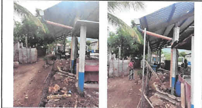
FOTO 1: FUNDICIÓN Y ALINEACIÓN DE POSTES DE TUBO GALVANIZADO Y CIMENTACIÓN
