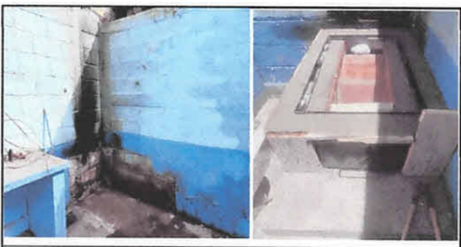
FOTO 5: CONSTRUCCIÓN DE ESTUFA
