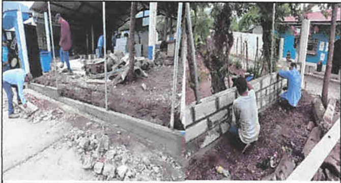
FOTO 3: CIMENTACIÓN, CENTRADO DE POSTES Y LEVANTADO DE MURO DE BLOCK
