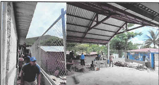
FOTO 4: COLOCACIÓN Y TENSADO DE MALLA
